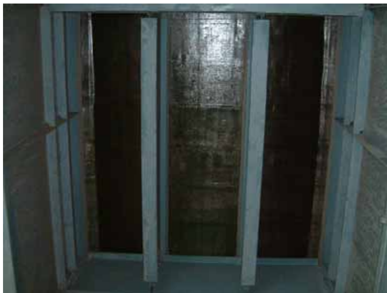
炭素繊維シート補強工
