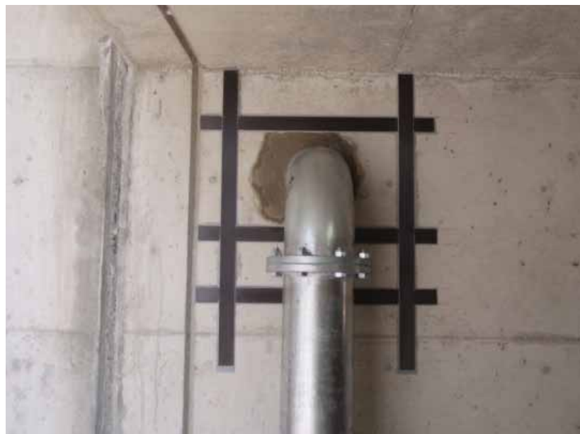
コンクリート壁コア部補強
