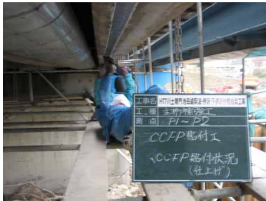
炭素繊維集成板取付
