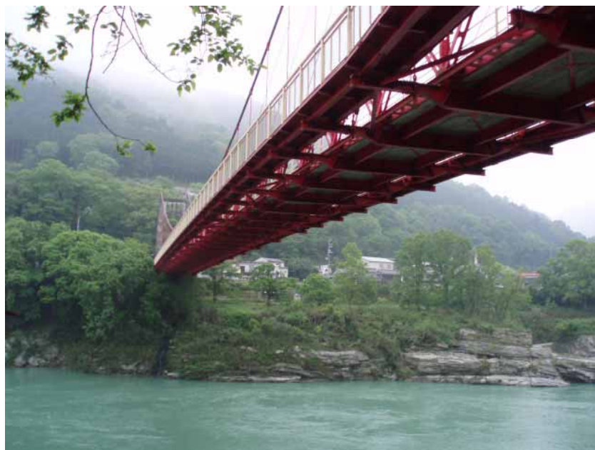
吊橋床板の補強
