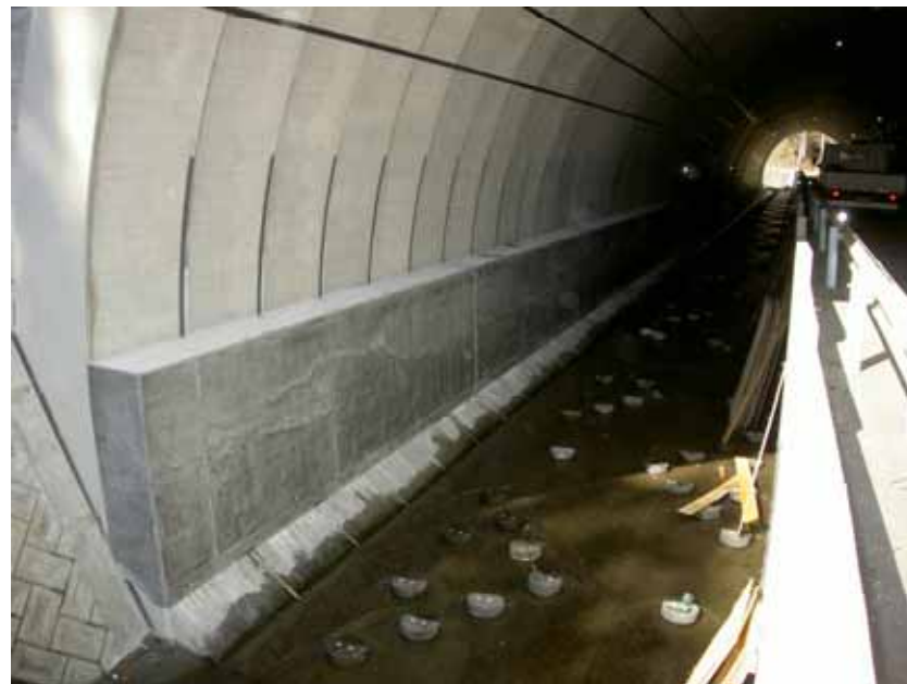
トンネルの補強
