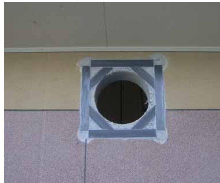
後施工ダクト孔の補強
