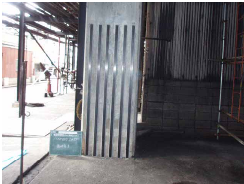
製油所コンクリート柱の補強
