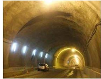
道路トンネル
