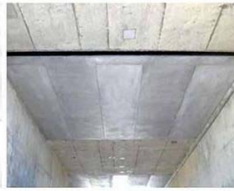
道路ボックスカルバート
