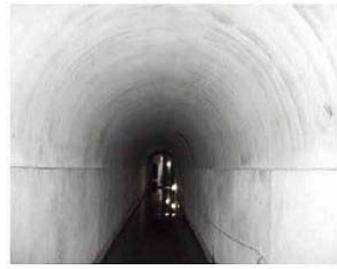
導水路トンネル
