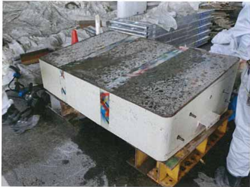
施工完了 右斜め前
