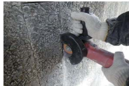
■カッター切り状況
