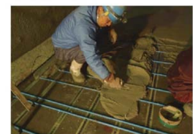
⑧ 保護被覆工・AT-PCM 中塗材塗布
