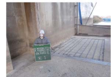
⑥ 鉄筋埋設定着工
