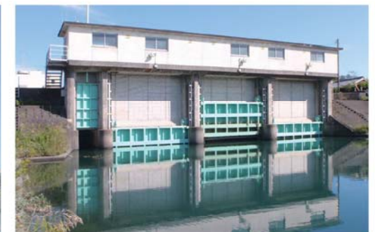
■ 海陽大里樋門
