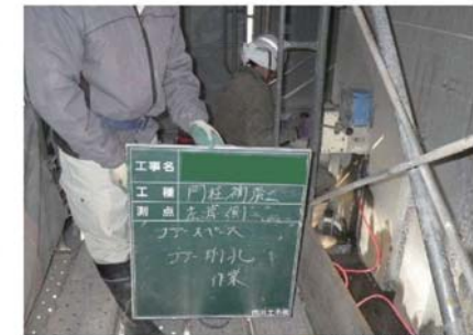
■壁面削孔状況
