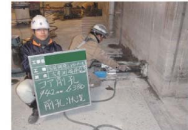
④ コア削孔工・専用削孔機
