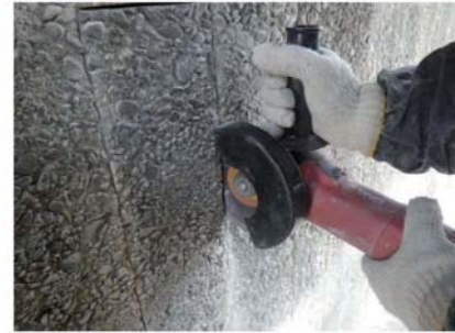
■カッター切り状況
