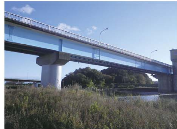
■ 岡島頭首工管理橋
