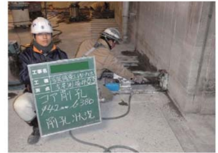
■水平削孔状況
