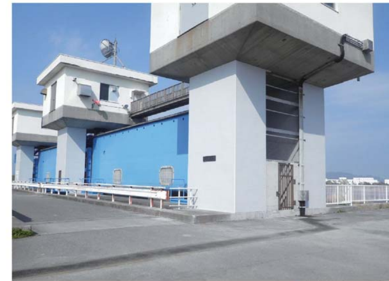
■ 安倍川丸子川水門
