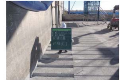
⑤ 埋設溝切削工
