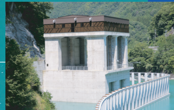
小渋ダム 土砂吐ゲート機側棟
