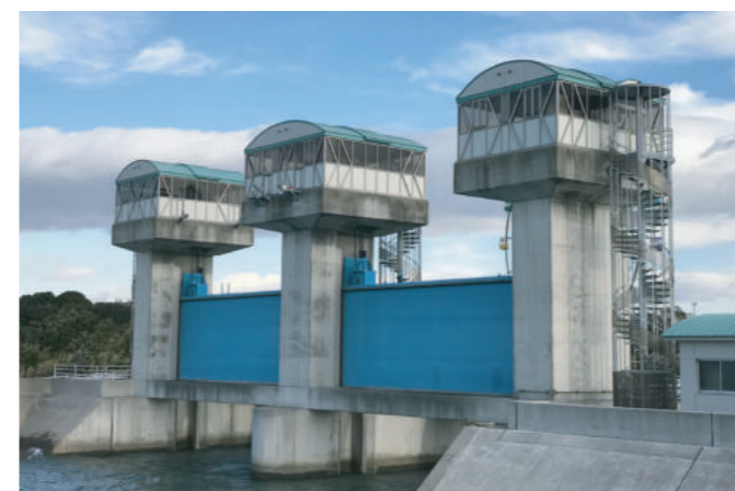
愛知県 知多建設事務所 山王川樋門 W=6,700 B=6,200 H=2,400
