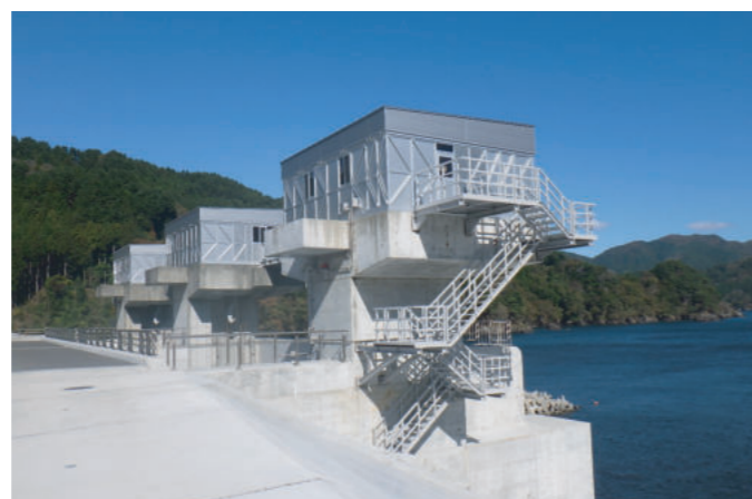
岩手県 沿岸広域振興局農林部 大船渡農林振興センター 下荒川水門 W=6,700 B=8,200 H=2,500
