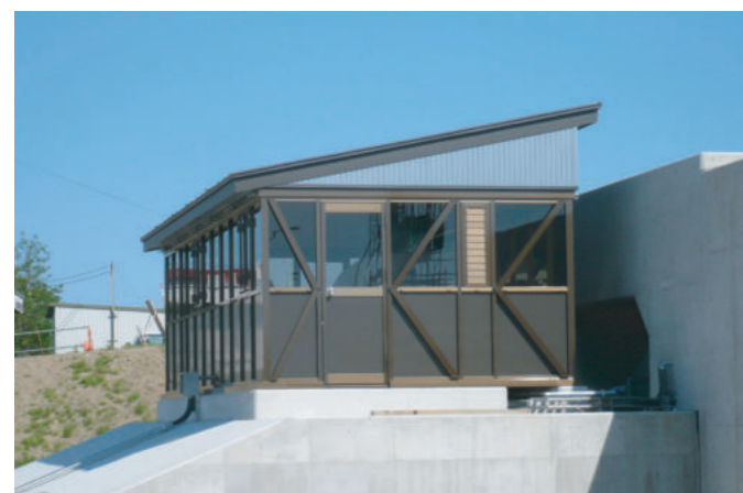
国土交通省 秋田河川国道事務所 新屋水門操作室 W=3,500 B=8,600 H=2,100
