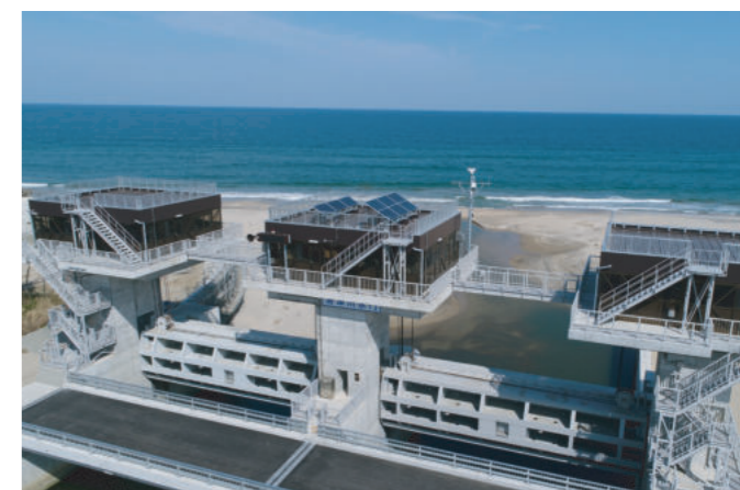
福島県 いわき建設事務所 滑津川水門 W=8,200 B=10,200 H=2,500
