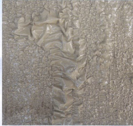
塗布後数時間経過状況
