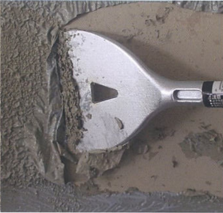
剥離作業状況
