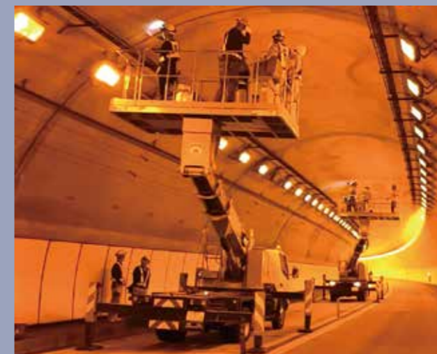
施工状況全景
