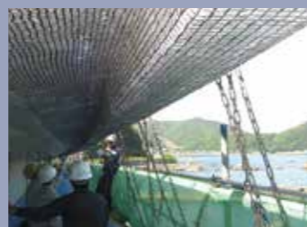
〈施工完了〉隅角部が密着している
