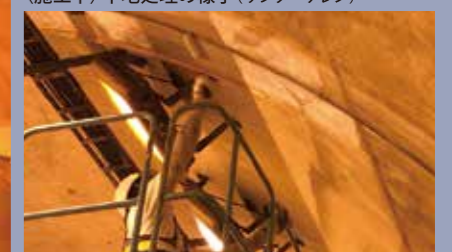
〈施工中〉1層目塗布の様子
