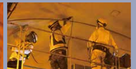
〈施工中〉下地処理の様子（サンダーケレン）
