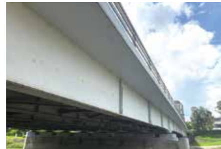
京都市役所 北山大橋補修工事
