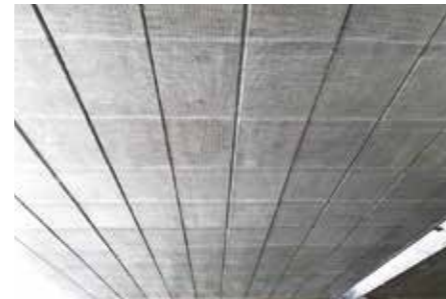
国土交通省 中国地方整備局 鳥取管内秋里歩道橋外橋梁補修工事
