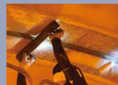
〈施工中〉BMシート貼付
