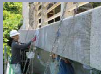
〈施工中〉BMシート工法の施工の様子
