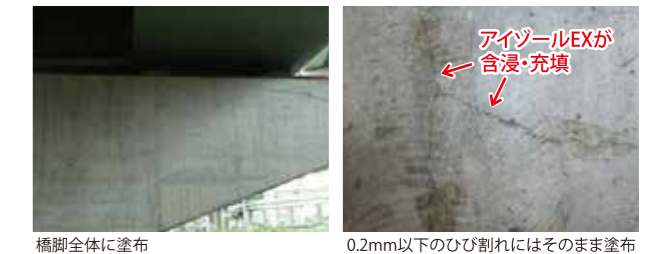
橋脚全体に塗布 0.2mm以下のひび割れにはそのまま塗布
