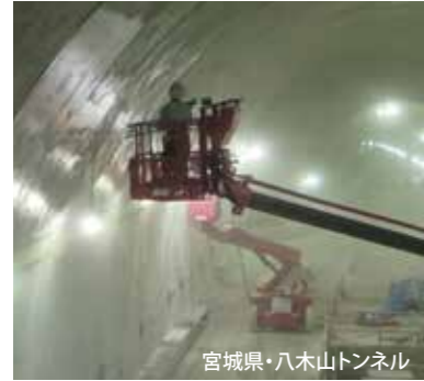
宮城県・八木山トンネル
