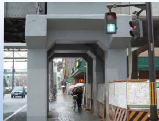
(近鉄京都線東寺駅島町高架 グレー色での施工)
