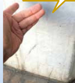
施工15年後の状況
