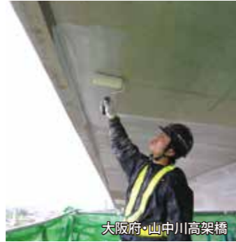
大阪府・山中川高架橋
