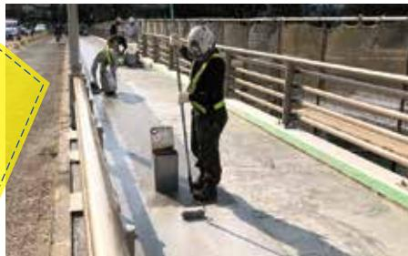
スプレダムシールE(含浸プライマー)は、コンクリートや鉄部など様々な素材に対する接着性が高く、コンクリートのひび割れや鉄部の亀裂にも深く浸透するプライマーです。スーパースプレダムG(塗膜防水)は透湿性塗膜のため、ブリスタリング(ふくれ)が発生しにくくなります。また耐薬品性に優れており、塩分の浸透抑制にも効果を発揮します。
