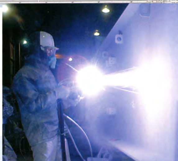
溶射の施工↑
