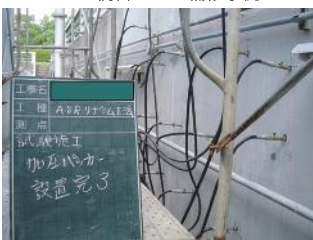
擁壁のASR補修事例
