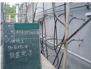
擁壁のASR補修事例
