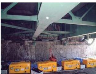
橋台のASR補修事例
