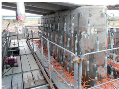
リハビリカプセル工法施工状況
