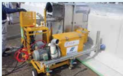
自動塗装機による壁高欄塗装工
