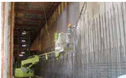
大型建物物地下防水工
