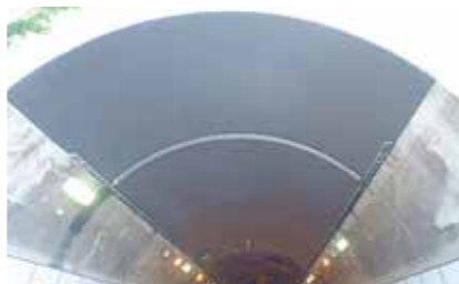
トンネル内剥落対策及び表面被覆工
