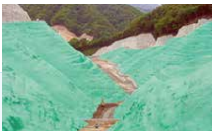
廃棄物処分場吹付遮水工
