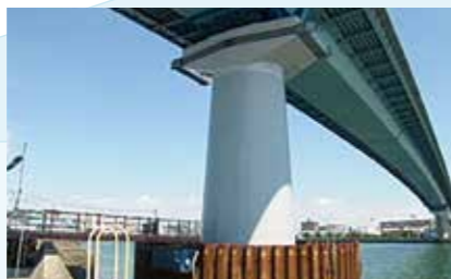
RC巻立保護塗装工
