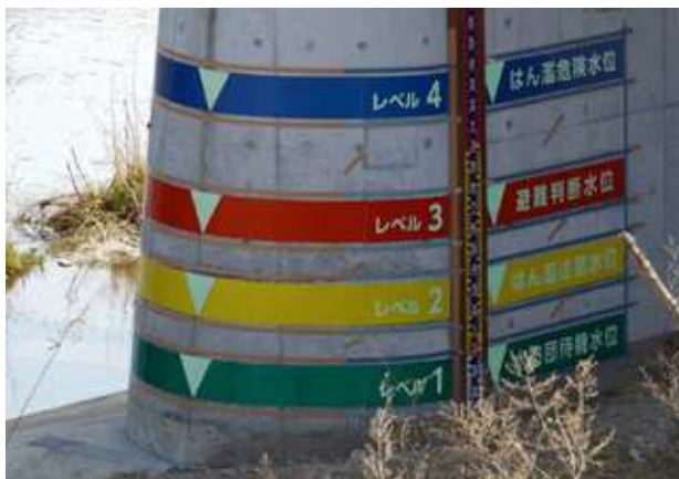
橋脚量水標(宮城県・気仙沼市)
