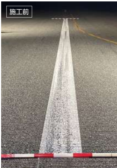
施工前の滑走路中央線
