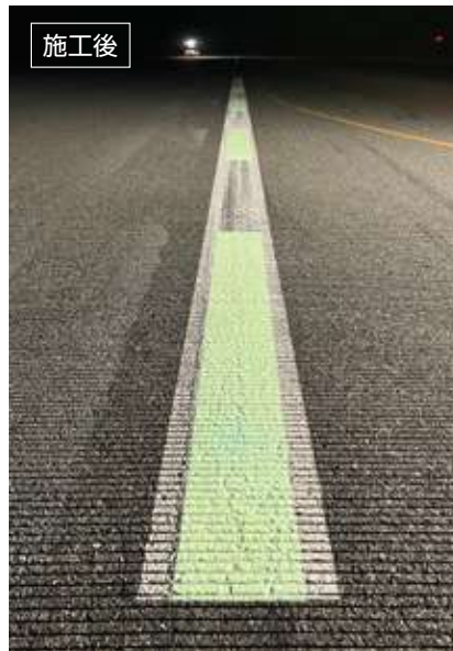
長さ3mの蓄光塗装を等間隔に施工
