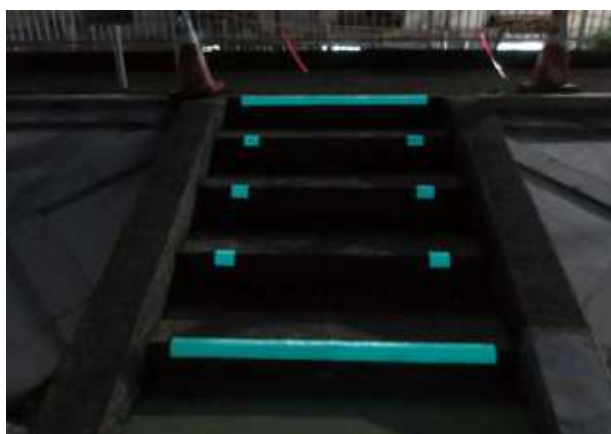
避難経路階段部分(東京都・大森南防災船着場)
