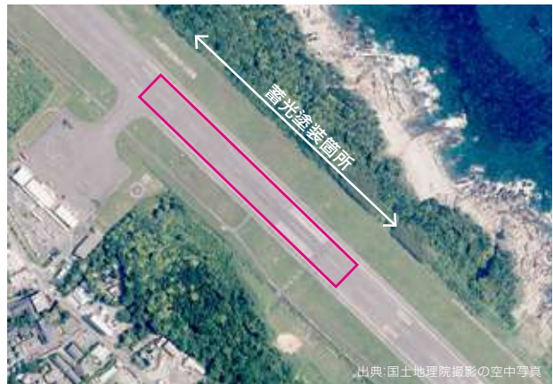
屋久島空港滑走路の中央線への塗装工事
