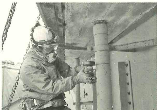
丸森町にある金栄橋の補修工事（写真提供：EARTH CREATE）
