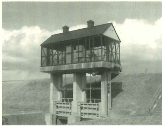
水門の上に建てられた上屋（写真提供：EARTH CREATE）
