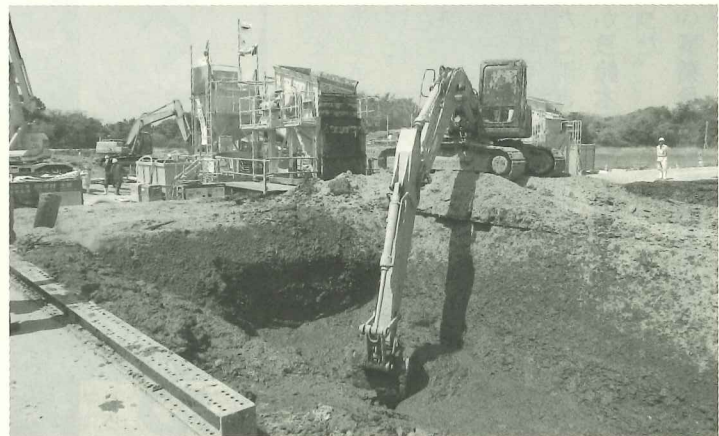
土壌改良固化材は東日本大震災で被災した塩竈市寒風沢島の復興工事に使用された（写真提供：EARTH CREATE）
